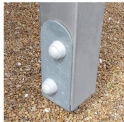
Réalisées en **acier, galvanisé à chaud** suivant les NF A91-121 et A91-122 et mises en couleur par **thermo laquage** polyuréthane par dépôt électrostatique ép. 100 microns (tenue minimum de 600 heures au brouillard salin).
