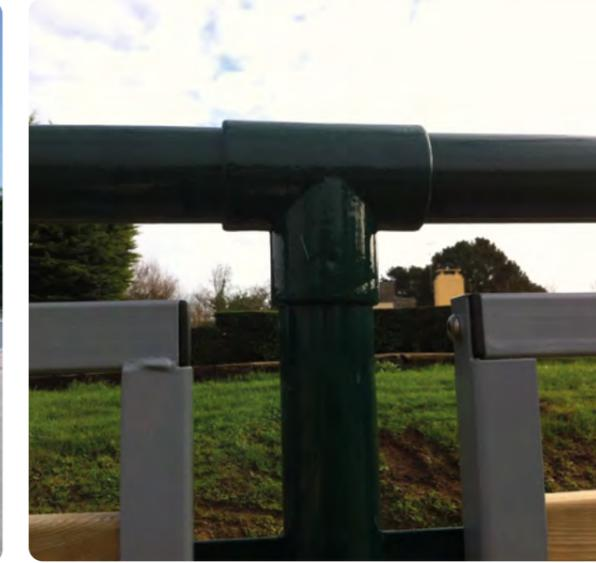
Équerrage par manchon tubulaire aluminium, sans soudure.
